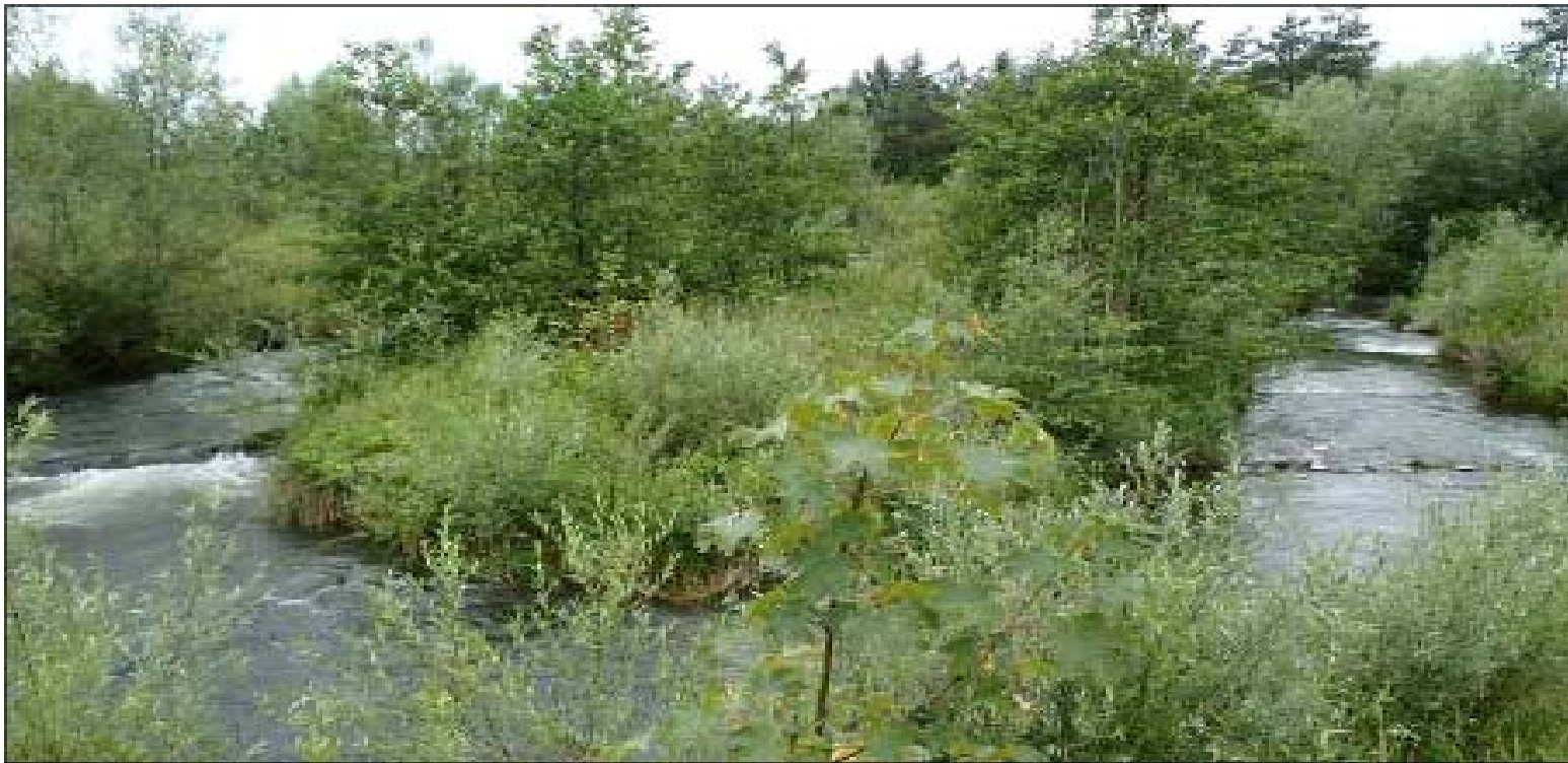
Мал 5.Рибохід греблевої ГЕС, який імітує природний рельєф річки, Австрія
